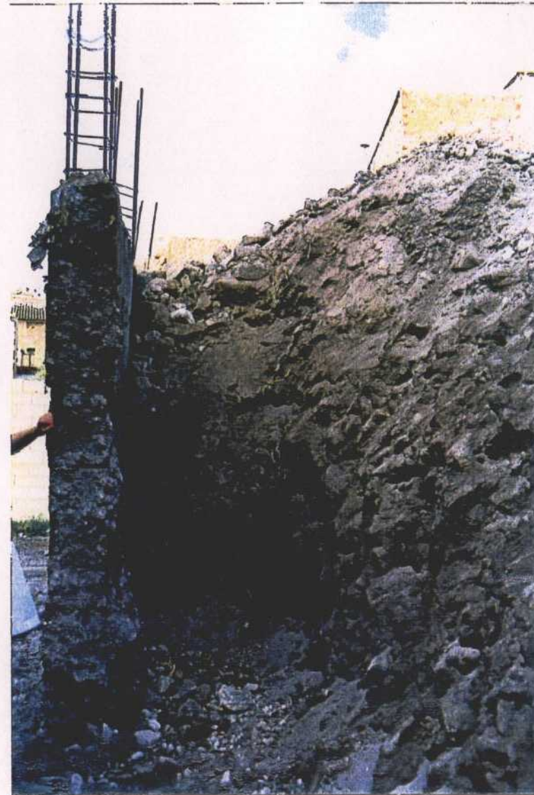
FOTOGRAFIAS 3A-3B. Potentes espesores de rellenos en la parte alta del Casco Antiguo. Muro de contención caído. (Situación: 3A. al fondo se puede ver la parte posterior de la Iglesia de San Patricio. Entre las Calles Gómez y Zapatería).
