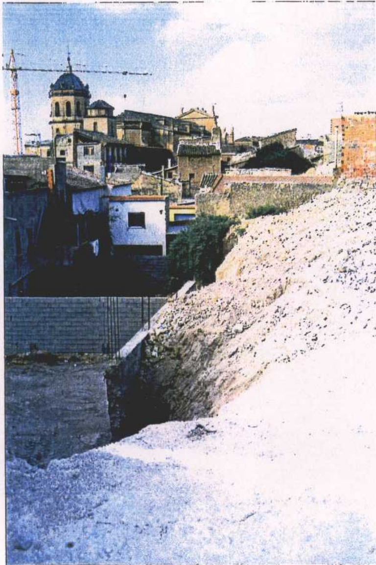
FOTOGRAFIAS 3A-3B. Potentes espesores de rellenos en la parte alta del Casco Antiguo. Muro de contención caído. (Situación: 3A. al fondo se puede ver la parte posterior de la Iglesia de San Patricio. Entre las Calles Gómez y Zapatería).
