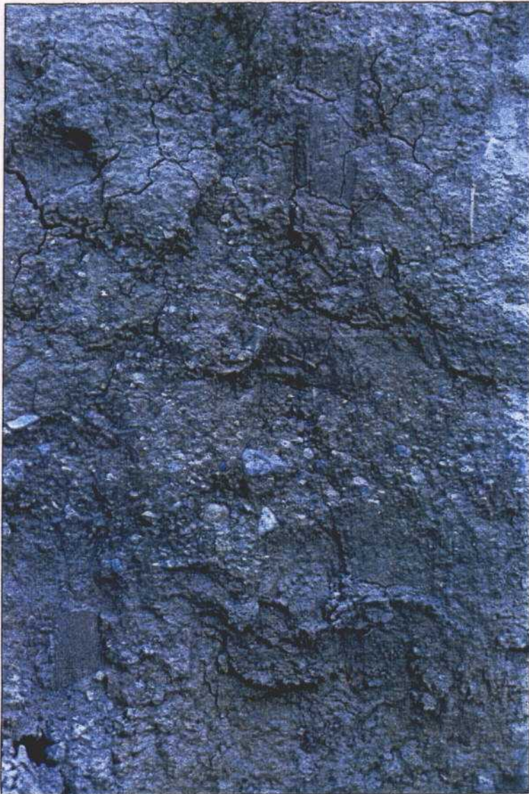
FOTOGRAFÍAS 2A-2B. Excavación y detalle de materiales limoarcillosos con pasadas de gravas y arena. Material de firmeza y consistencia variable, aunque generalmente alta. El contenido variable en arcillas produce retracción en el material al desecarse (expansivo). (Avenida de Juan Carlos I; cerca del Río Guadalentín).
