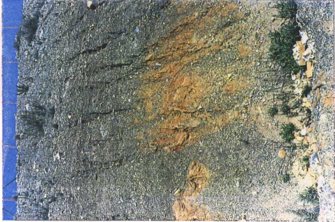
FOTOGRAFIA N° 4. Corte del terreno en un desmonte realizado en el Centro de Formación Profesional situado en el Barrio de San Antonio. Materiales coluviales, de carácter proximal sobre una formación conglomerática de tonos rojos.
