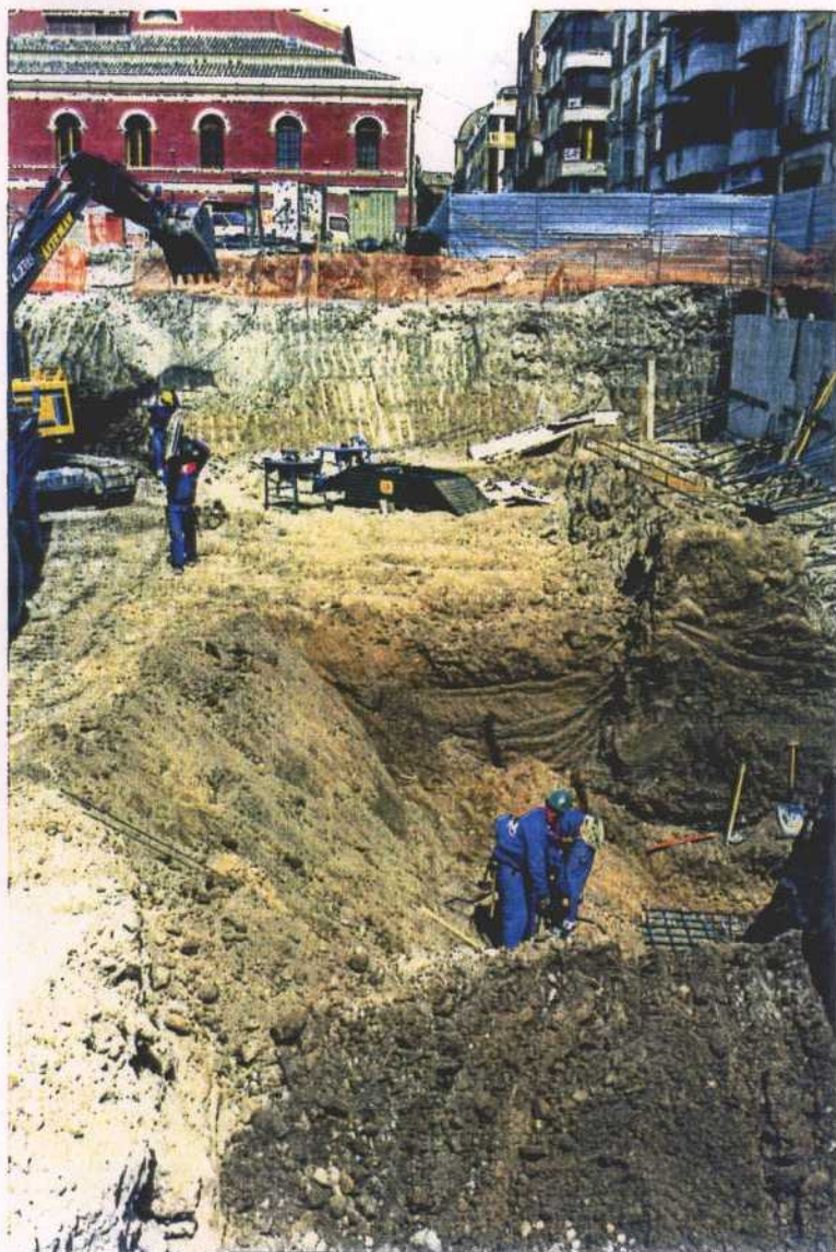
FOTOGRAFIA N° 6. Corte del terreno en excavación del parking, en construcción, de la Plaza de Colón. Materiales de origen aluvial, con contenidos altos en finos (limos y arcillas) en este tramo medio-distal del punto de origen. Materiales semicompactos de firmeza variable, generalmente flojos.
